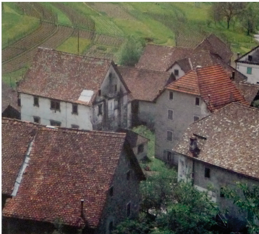
Tetti con panelas a Ovaro
